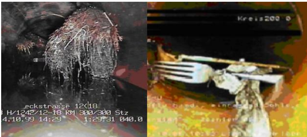
Verstopfter Zuleitungskanal
